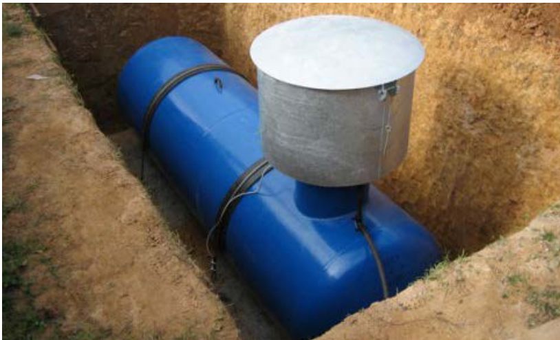
Рис. 1.3. Подземное размещение резервуара (газгольдера) для хранения СУГ
