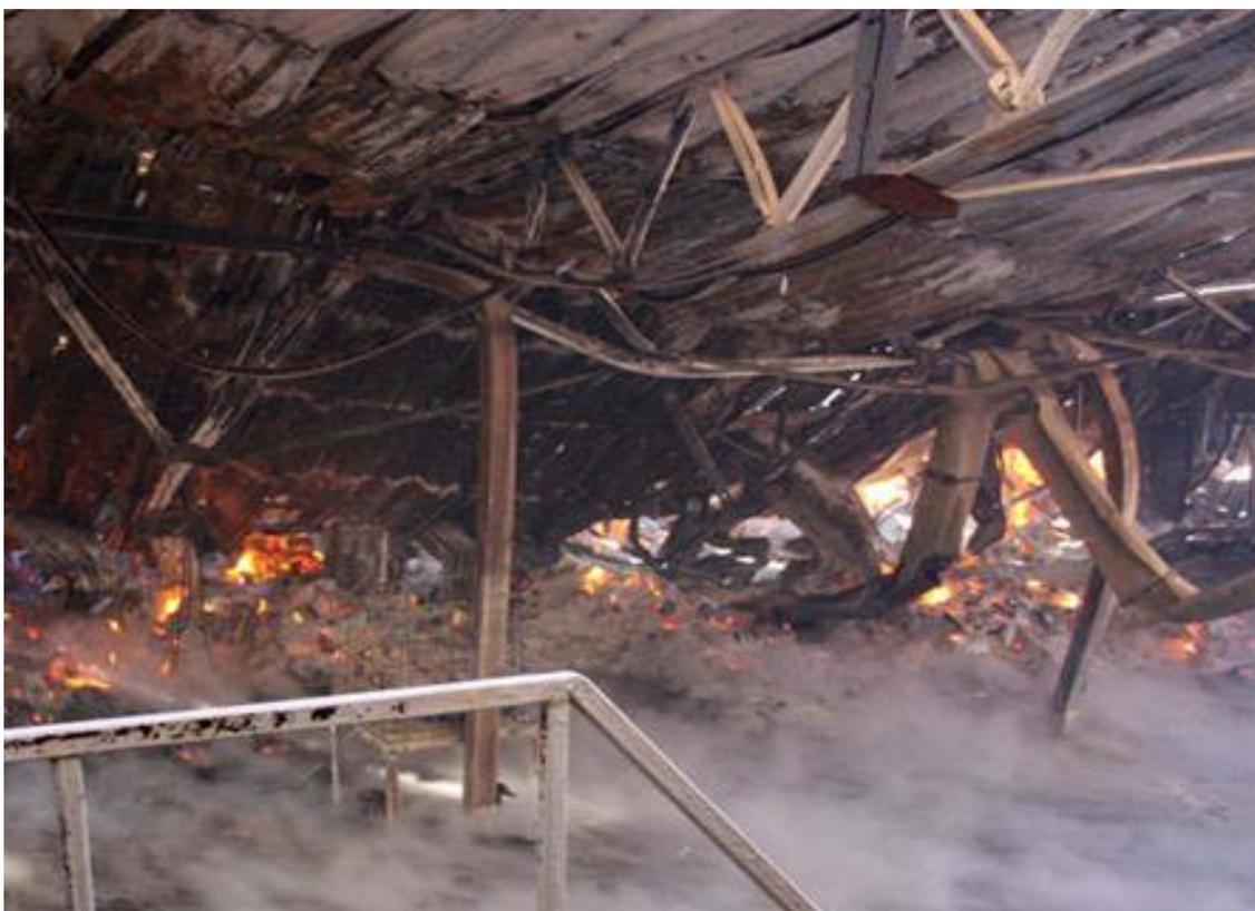
Рисунок 18. Деформация металлических конструкций на пожаре
