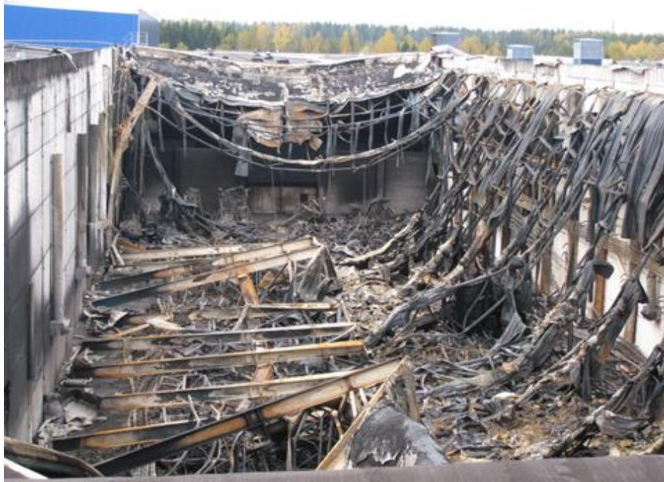
Рисунок 19 Деформация металлических конструкций на пожаре
